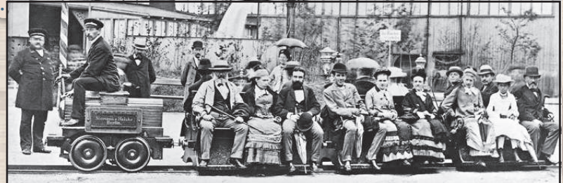
Die erste elektrische Lokomotive gebaut von Werner von Siemens, 1879
